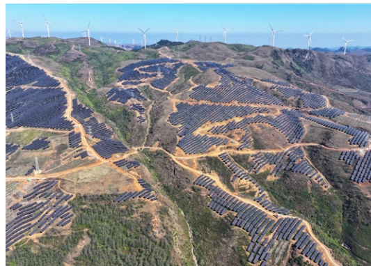
中國宏橋雲南新能源光伏項目（二）
