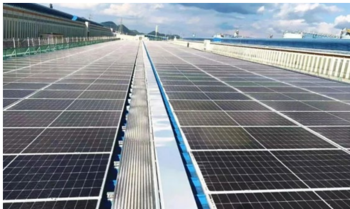
雲南宏泰工廠屋頂安裝光伏面板
